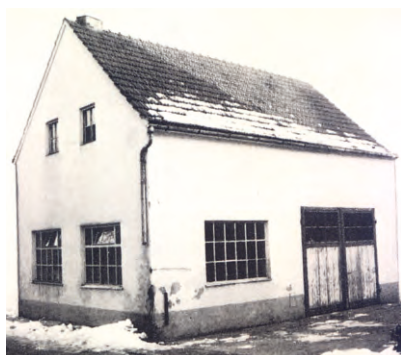
Firma Martin Reisch bei Firmengründung - Ansicht 1951
